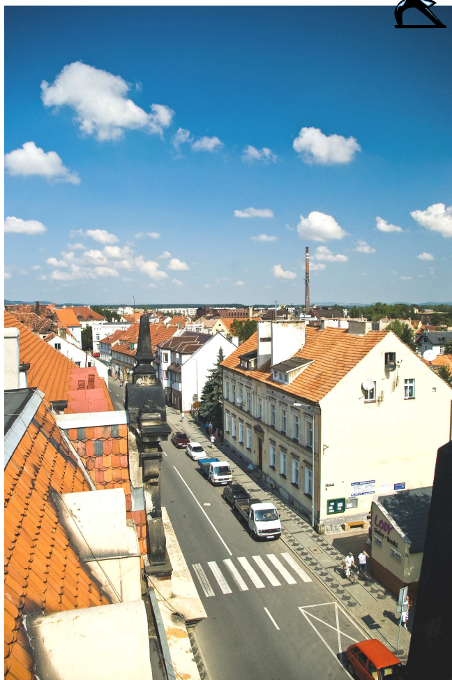
Widok fragmentu ulicy Świdnickiej.
